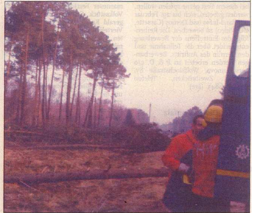
THW-Mitarbeiter aus Pirmasens halfen in Frankreich, die Sturmschäden zu beheben.
