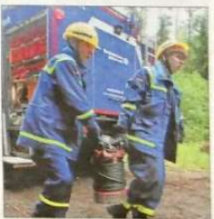
Schwere Pumpen müssen an den Bach getragen werden.
