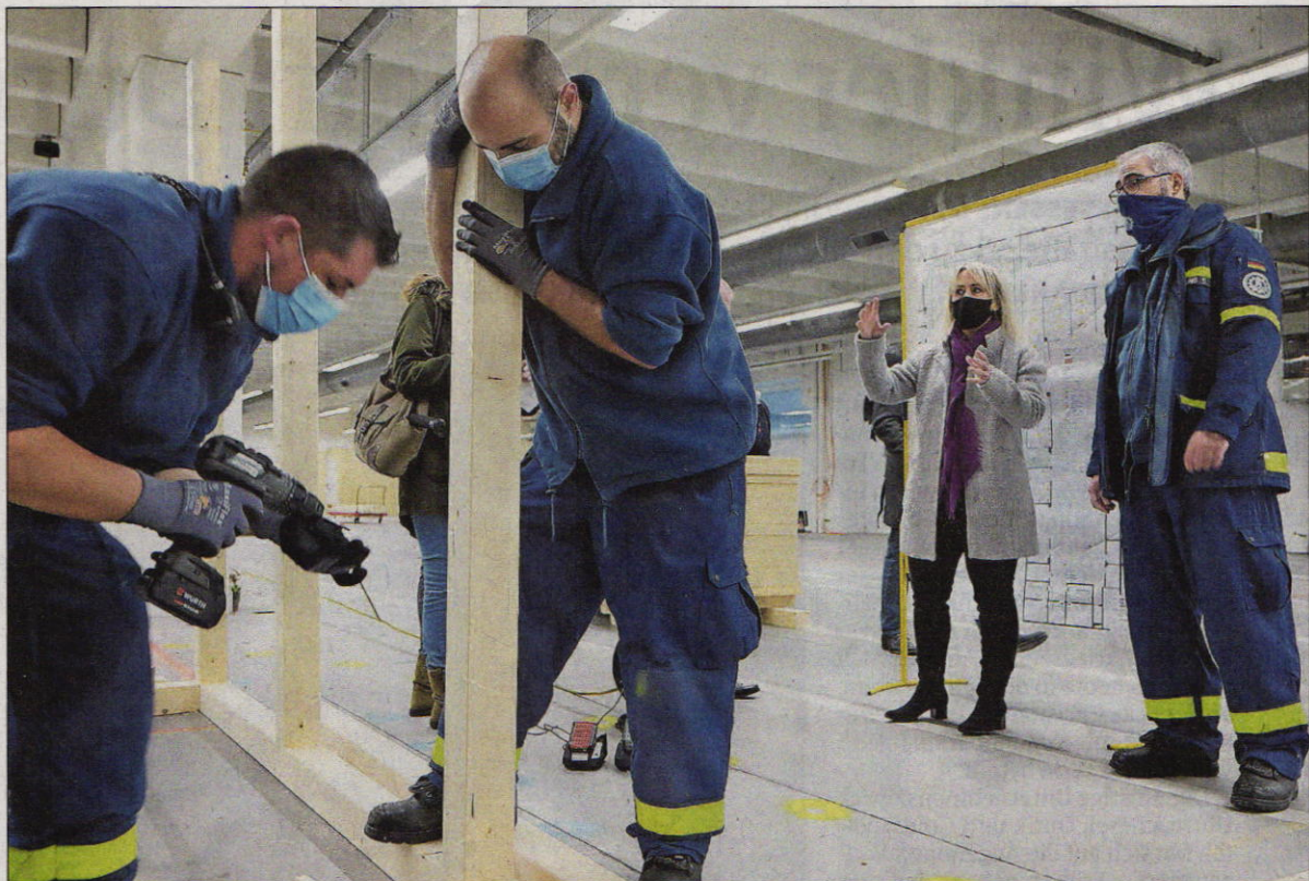
THW-Helfer bauen Rahmen für die Arztzimmer des Impfzentrums. Landrätin Susanne Ganster (Zweite von rechts) informiert sich vor Ort über den Fortgang der Arbeiten.
