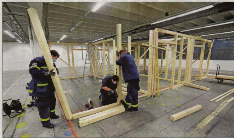
Für die Räume des zukünftigen Corona-Impfzentrums in der Messehalle 6c bauen die Pirmasenser THW-Helfer momentan Holzständerkonstruktionen auf: Am 15. Dezember soll es betriebsbereit sein.
