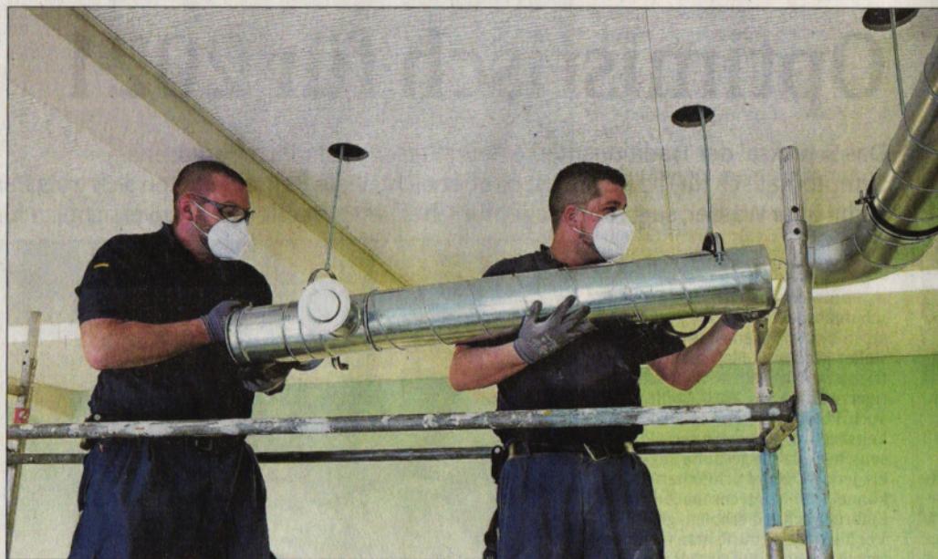
Das THW installiert Lüftungsanlagen: Markus Krämer (links) und Steven Friedewald in der Horebschule. FOTO: SEEBALD
